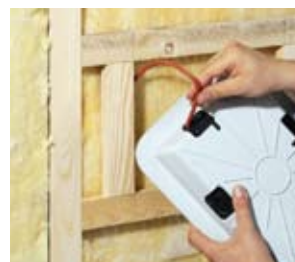
Mit innenliegendem Wechsel. Montage avant pare-vapeur.
